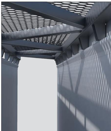
□ Верхние узлы крепления полотна
