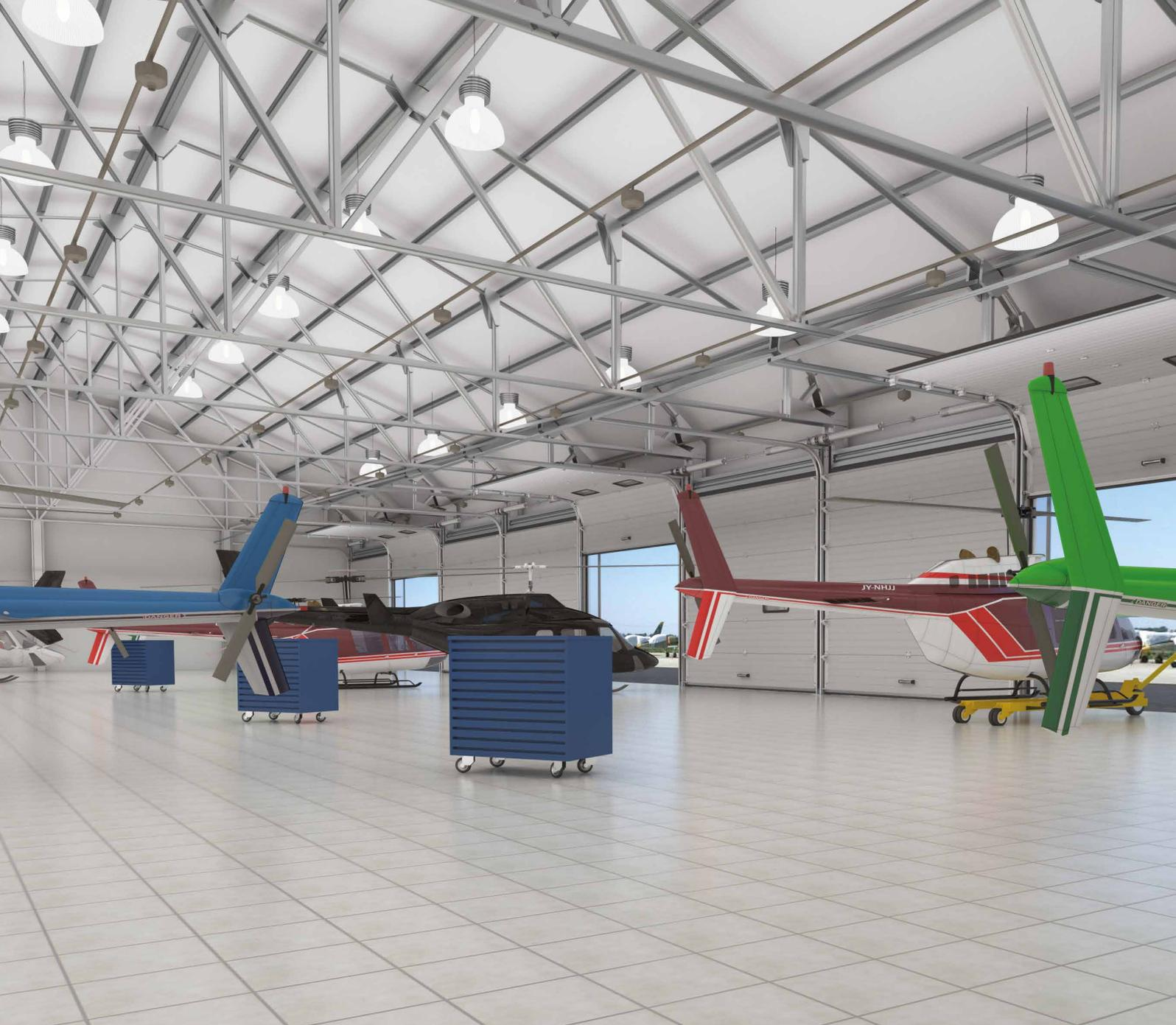
Тенто-мобильная конструкция представляет собой каркасно-тканевое сооружение с механически напрягаемым тентовым покрытием. Мобильность ТМК выражается в возможности повторения операций монтажа, демонтажа и транспортировки без снижения прочности и функциональности всего сооружения.
